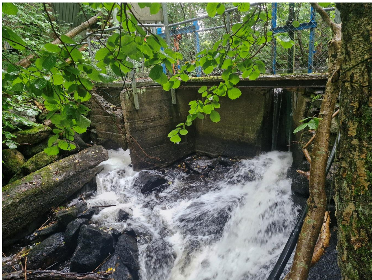
Figur 8. Dammen nedströms Benarebyvägen, vandringshinder 2 för Nordsjöbäcken.
